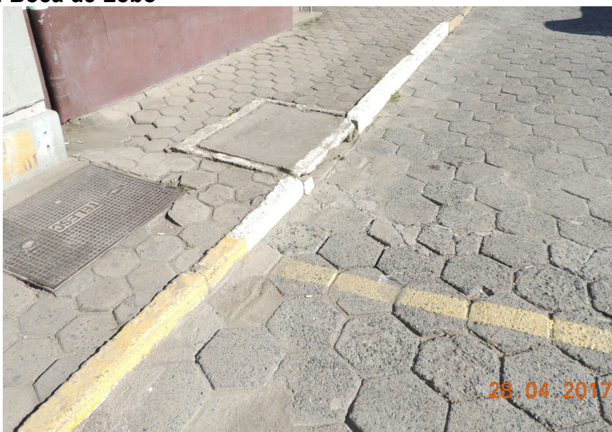
Foto 21: Boca de Lobo
